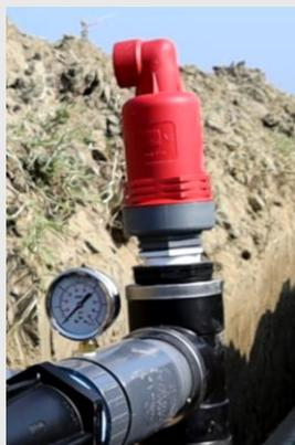
**Клапаны-вантузы** для предотвращения засасывания примесей при опорожнении капельниц (даже при использовании антисифонных капельных трубок).
